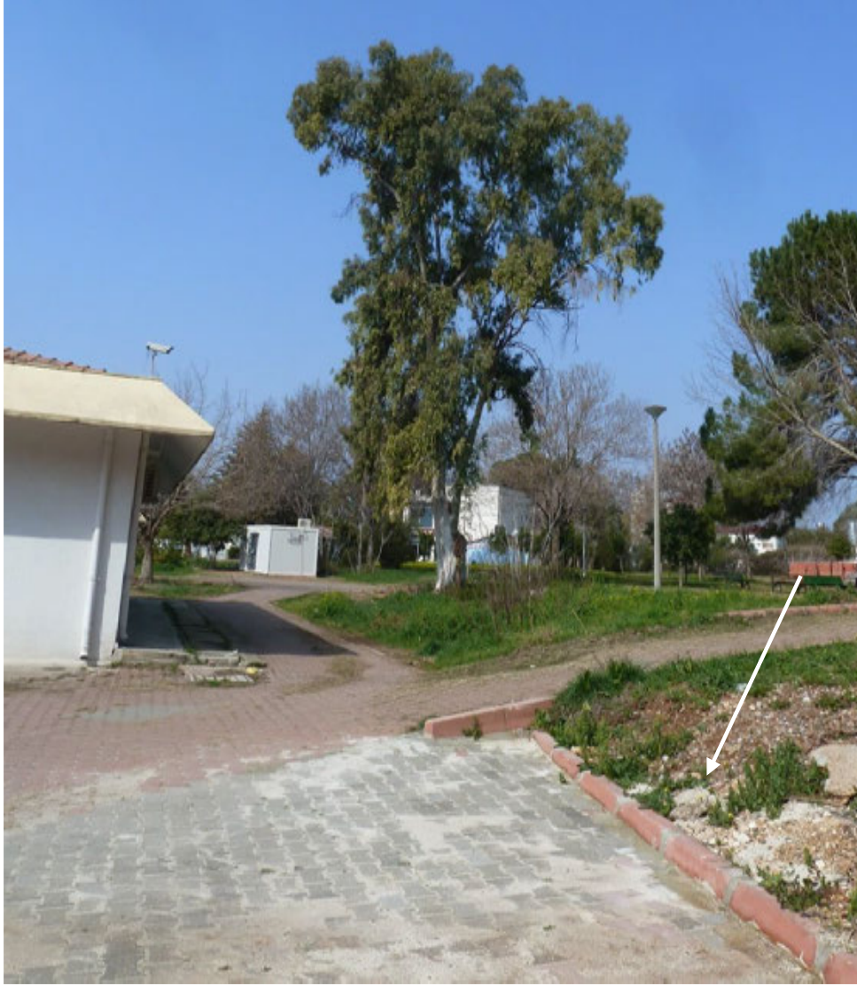
Kültür Müdürlüğü ve Güzel Sanatlar Bölümü arka kısmında istinat duvarı gerektiren alan
